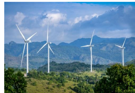
DA Điện gió tại Gia Lai
