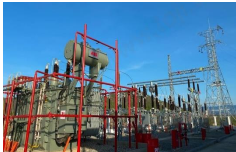
DA Điện mặt trời tại Ninh Thuận
