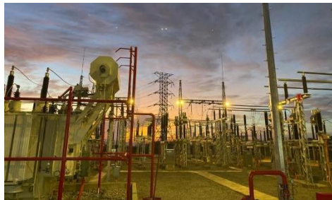
DA Điện mặt trời tại Ninh Thuận
