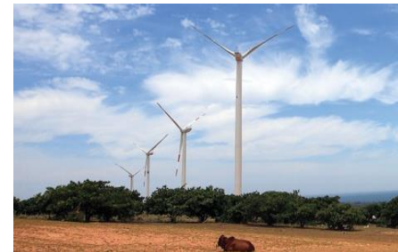
DA Điện gió tại Ninh Thuận
